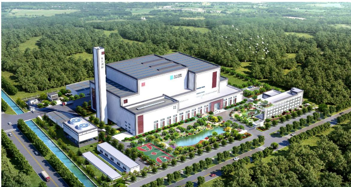
乐陵光大环保能源有限公司是中国光大国际有限公司旗下投资子公司,公司投资承建的乐陵市生活垃圾焚烧发电项目位于乐陵循环经济示范园园区八路以北,曙光路以东,占地75.9亩,建筑面积32387.95平方米,项目总投资5.89亿元人民币。项目工程规模为日处理生活垃圾1000t/d,分两期实施,同步投运。一期、二期工程规模均为日处理生活垃圾500t/d,总计配置二条500t/d垃圾焚烧线,9MW、12MW两套汽轮发电机组。项目总投资为人民币5.9亿元,年焚烧处理生活垃
